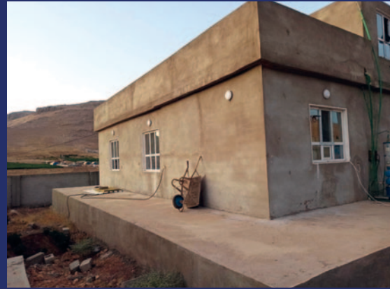
Kurdistan, costruzione dell'Ospedale di Shengal
